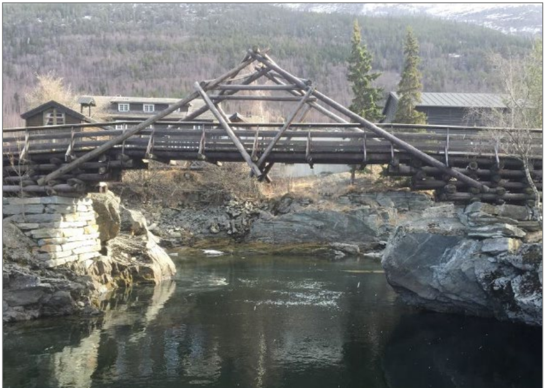
Gangbru over Bøvra. Kai Fjelstad 2015.
