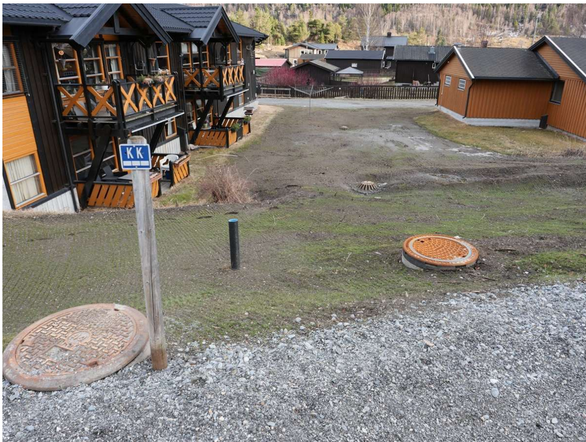
Figur 4: Ved nordaustgrensa for planområdet er det kommunale leidningsnett nyleg oppgradert. Det gjeld også overvassleidningar og kummar/sluk.
