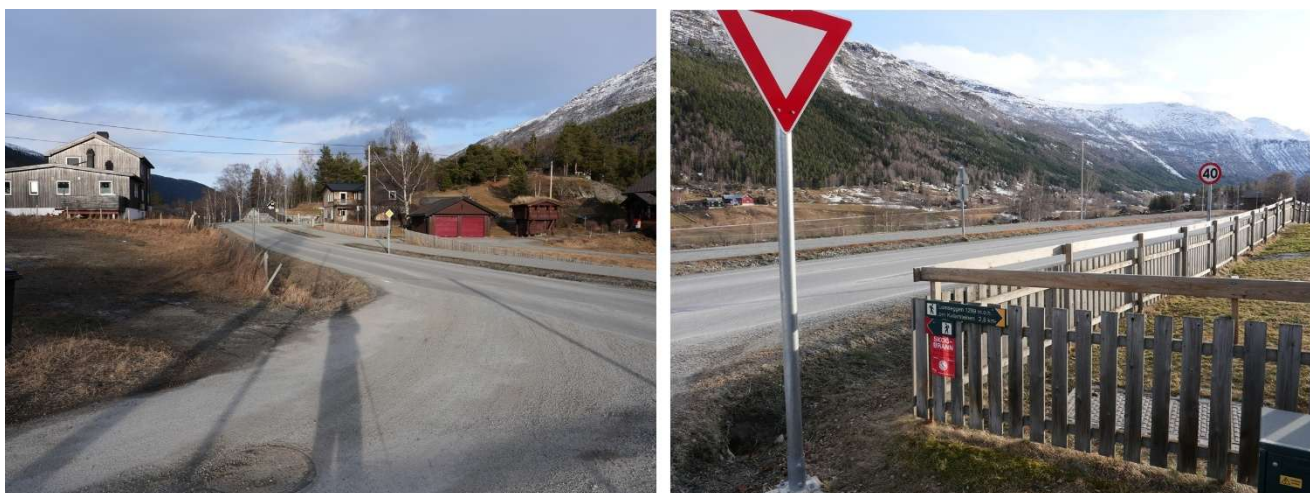
Figur 5: Foto av krysset mellom Røyskattlivegen og fylkesveg 2638 Solsidevegen - teke ca. 6 m inn frå kanten av sistnemnde. Bildet til venstre viser at sikte nordaustover er god. Bildet til høgre viser eit gjerde som er oppsett inn mot kryss. Gjerdet er i konflikt med siktretkant som føreset ingen hindringar over 0,5 m høgde. Foto teke 19.03.2026 av Øyvind Pedersen.
