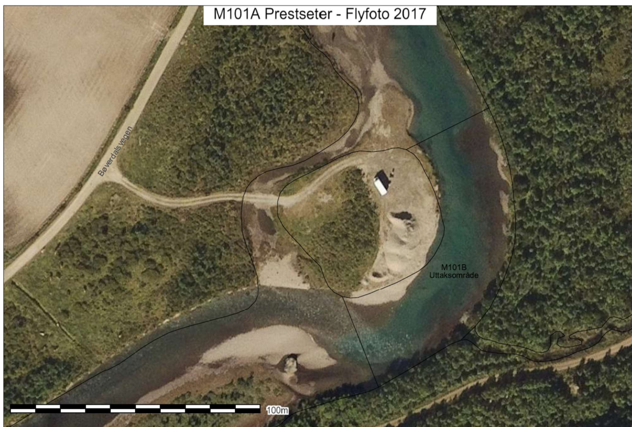
Flybilde frå uttaket ved Prestsæter frå 2017. Det ser ut som at lagring av grus framleis skjer på øya ved uttaksområdet, og ikkje i det gamle massetaket (M101B) som fastsett i reguleringsplanvedtaket frå 1998.
