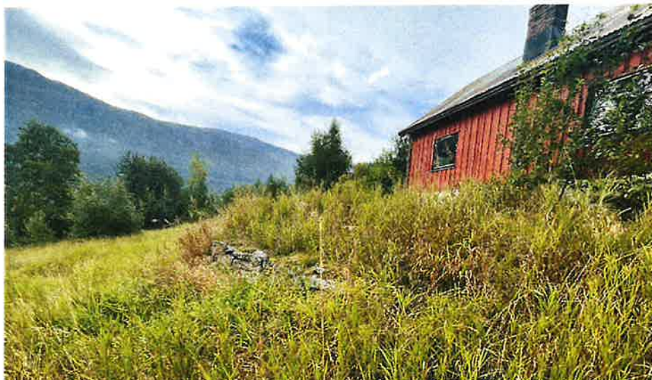
Figur 1: Eksisterande bustadhus til høgre i biletet. Sett mot sør.
