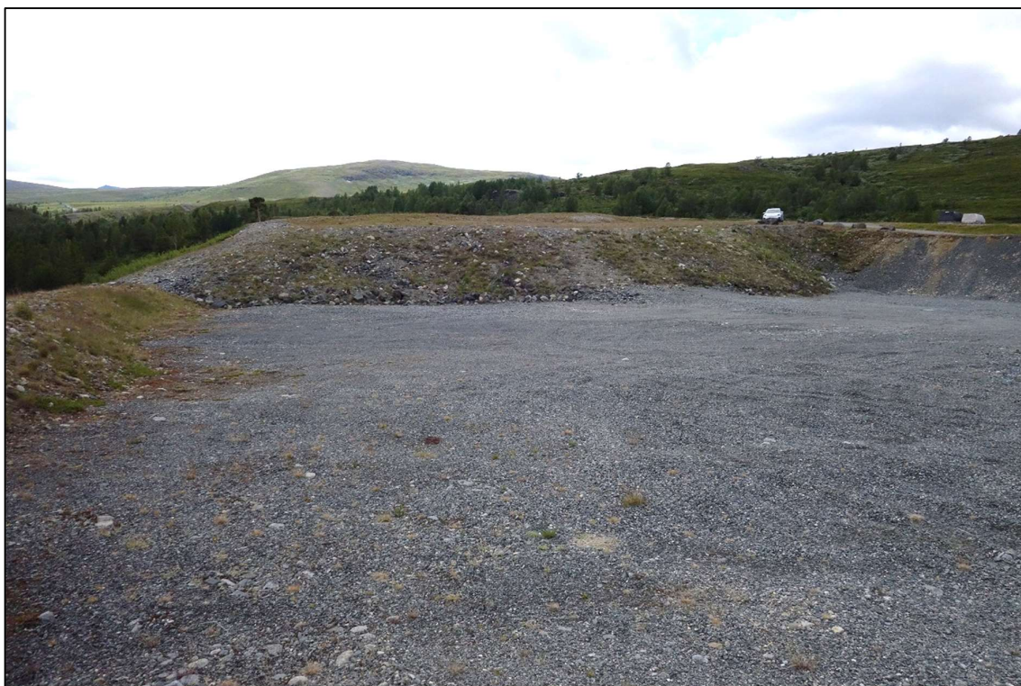
Illustrasjon 10. Det permanente massedeponiet etter kraftutbygginga på søraustre del av Kyrkjeflaten (i bakgrunnen av bildet), er lagt opp til same høgde som tilkomstvegen inn frå Veodalsvegen. Flata i framgrunnen er lager av massar frå kraftutbygginga for uttak og bruk på veganlegget. Massane her består av sprengstein som er dekt over med eit gruslag for tryggleik/tilkomst (foto Ø. Pedersen 2024).
