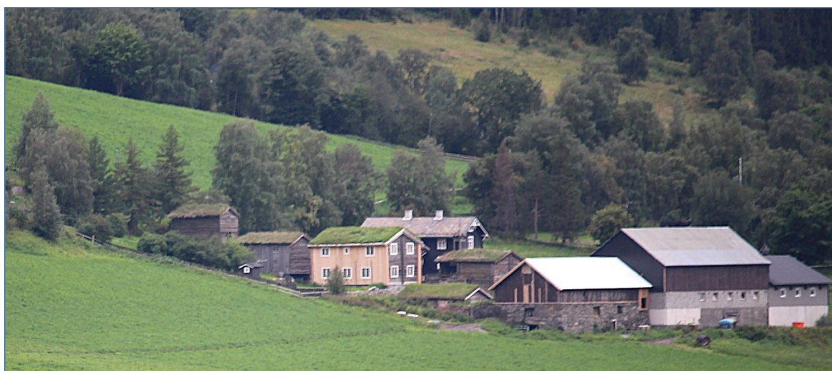
Figur 5-36 Stamstad Sygard (Askeladden id. 86364) med sju freda bygningar. Stabburet, bygningen lengst til venstre, ligg få meter frå dagens rv. 15. Foto Tine Eikehaug, Statens vegvesen.
