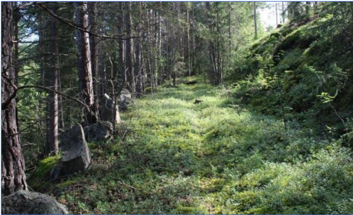
Figur 5-50 Del av eldre veg med stabbesteinar og utvendig tørrmur på nedsida av rv. 15 ved Rådsbakken. Foto Tine Eikehaug, Statens vegvesen.
