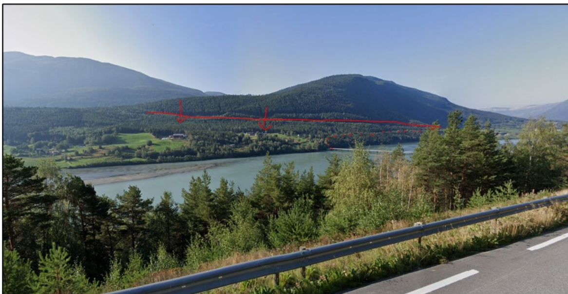
Figur 7-2 Nedanfor Raudberget (i Rådsbakken) vil breiddeutvidinga av rv. 15 resultera i hovudsakleg to større fyllingar som blir eksponerte ut mot dalen. (Kjelde: Google Maps)
