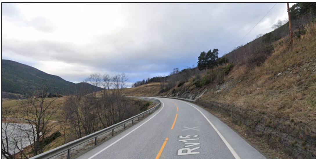
Figur 7-13 Døme på bruk av torvmur langs rv. 15, sør for Vågå, Søndre Snerle, for å redusera terrenginngrep i bratt terreng
