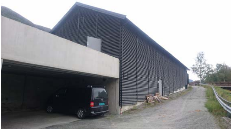
Eksisterande lagerbygg og carport. Støttemur mot elva ligg under autovernet til høgre i biletet.
