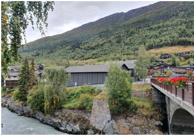
Eksisterande situasjon med lagerbygget sett frå brua.
