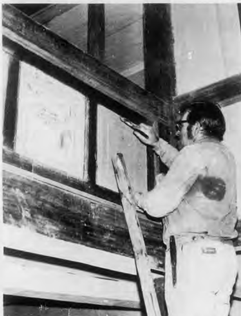
Ragnvald Asen har skrapa gammel måling og lagt på ny både i tak og vegg m.m. På den kvite spilen til venstre er det ein inskripsjon frå 1786. Riksantikvaren skal sjå nærmare på kva dette kan vera for noe.
