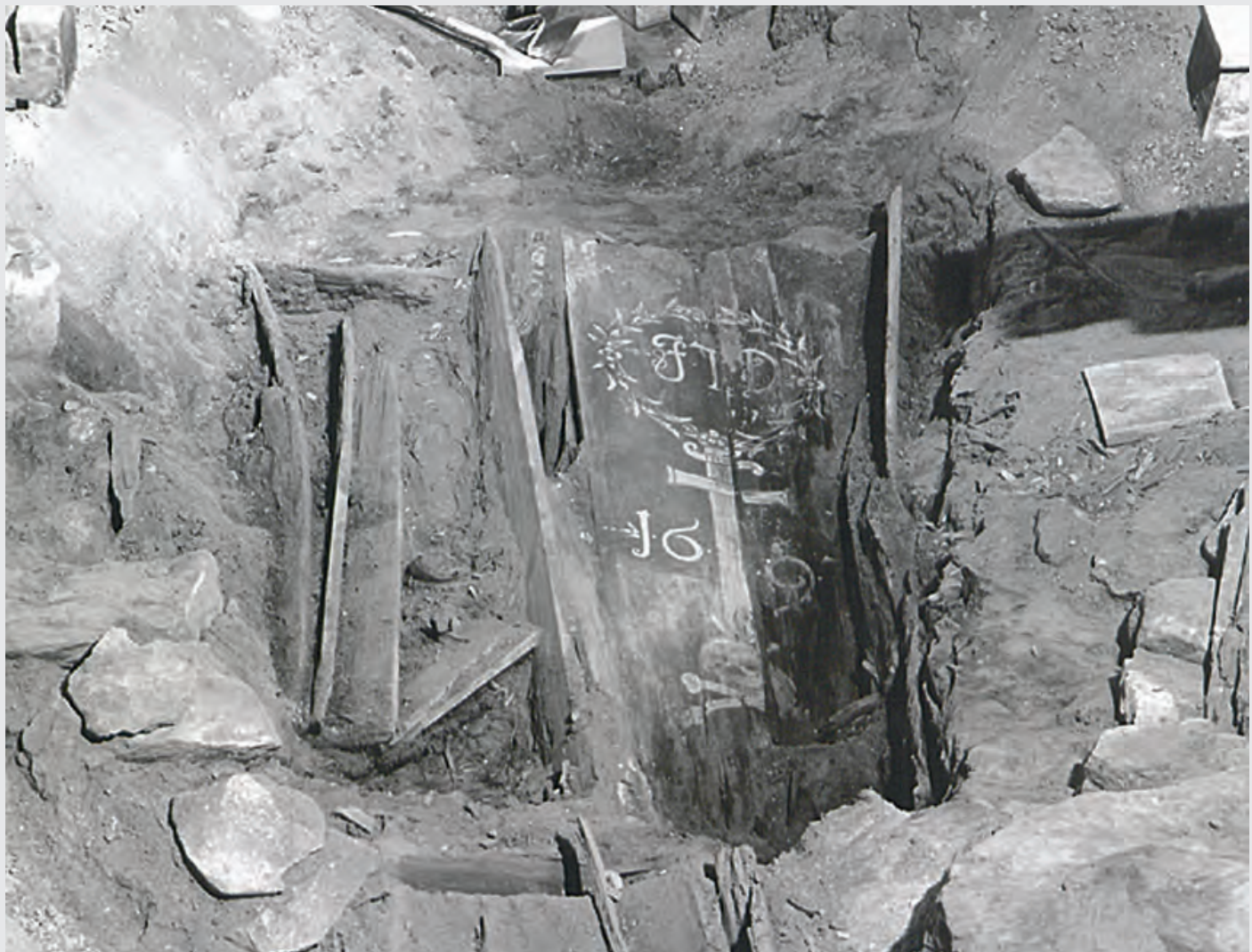
Frå restaureringa av Lom stavkyrkje, kister under golvet. Bilde frå arkivet til Lom knipsarlag / Visus.
