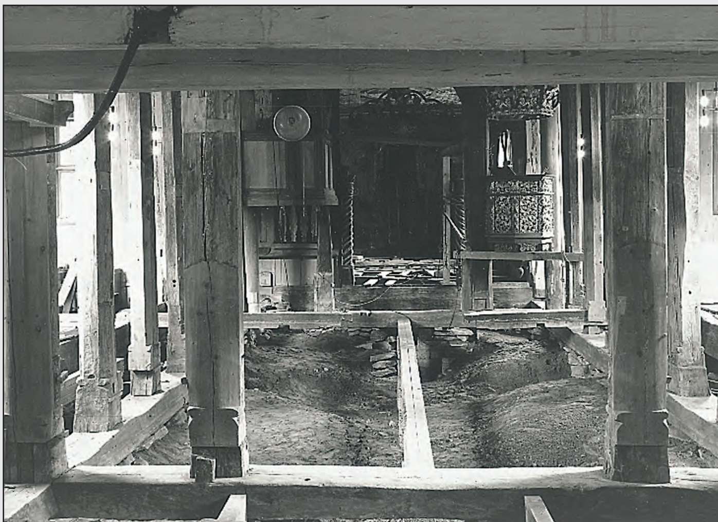
Frå restaureringa av Lom stavkyrkje. Bilde frå arkivet til Lom knipsarlag / Visus.
